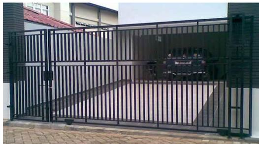
Gambar 2.6 Pintu pagar kombinasi (*Sliding gate combination*)
