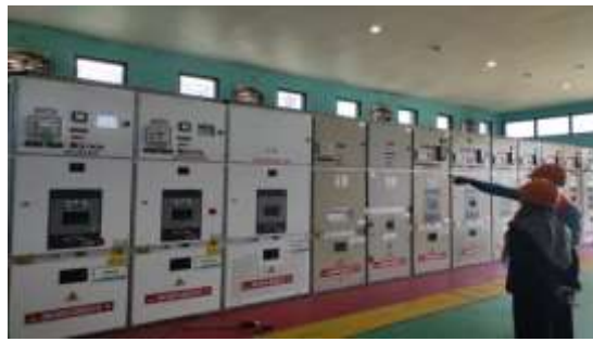
Gambar 2.1 Kubikel Tegangan Menengah
