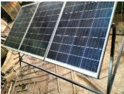
Pemasangan Panel Surya di Bingkai Panel
