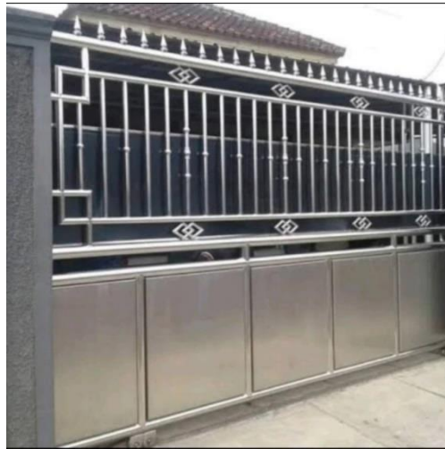
Gambar 2. 4 Pintu Pagar Geser Tunggal
