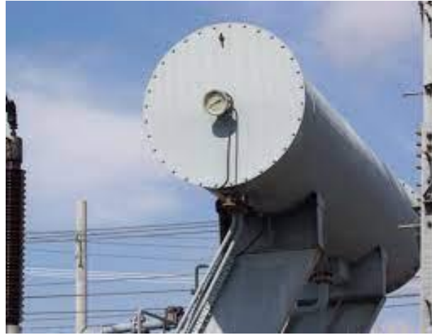
Gambar 2.27 Gasket/seal antara flage bushing dengan body Konservator
