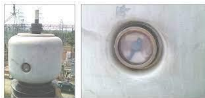
Gambar 2.25 Indikator level minyak bushing
