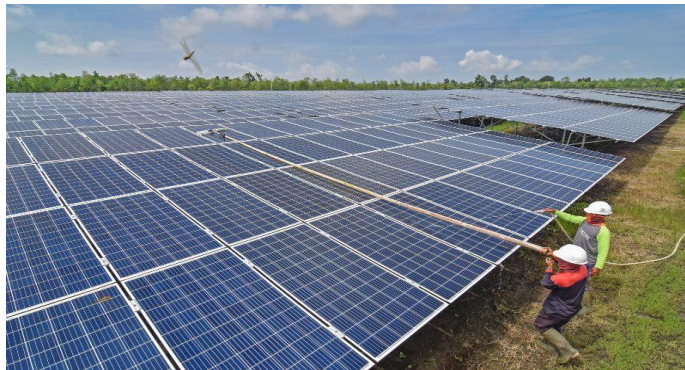
Gambar 2.5 Pembangkit Listrik Tenaga Surya 9
