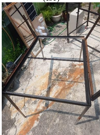
Perakitan Kerangka Solar Panel
