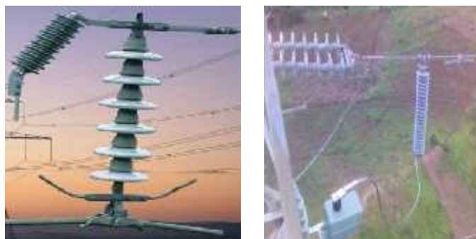
Gambar 2.15 Arrester di Saluran Transmisi
