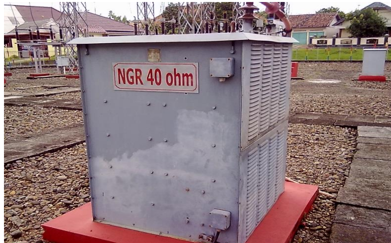
Gambar 2.10 NGR Pada Transformator 4
