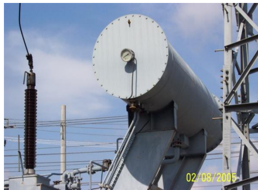
Gambar 2.5 Konservator minyak trafo (tangkai)
