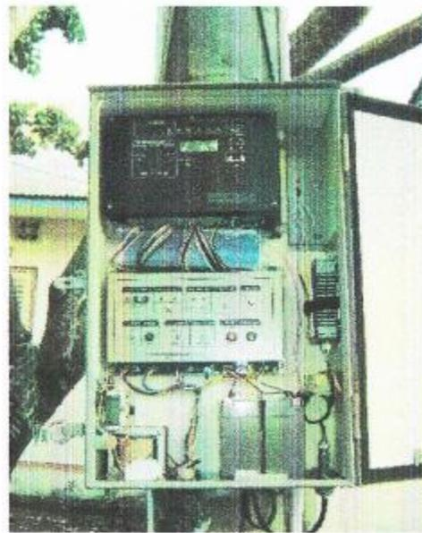
Gambar 2.8 Kotak Panel RTU dan LBS
