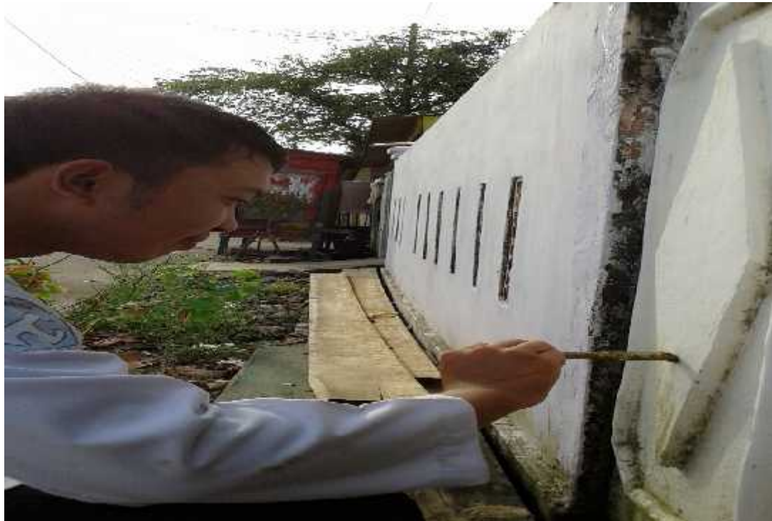
Pengaplikasi Cat pada tembok
