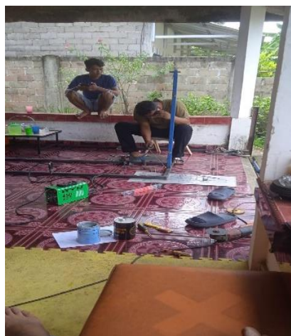
Gambar L3. 5 Pengelasan Rangka Panel Surya
