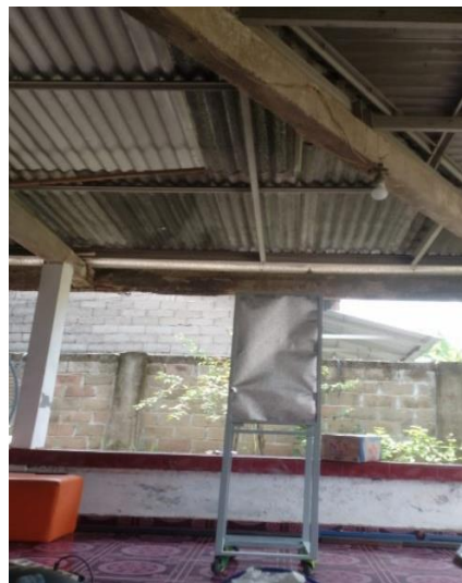
Gambar L3. 4 Memasang anti panas pada dinding oven dryer
