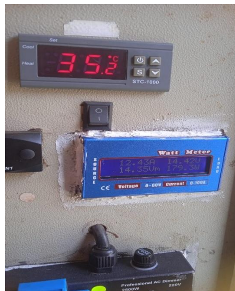
Gambar L3. 13 Mengambil Data Tegangan, Arus, dan Daya Panel dan mengatur setpoint temperatur
