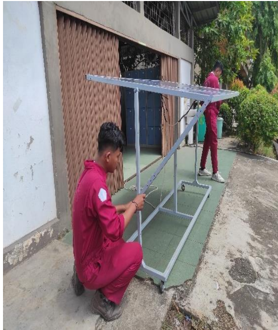
Gambar L3. 12 Mengatur Panel Surya
