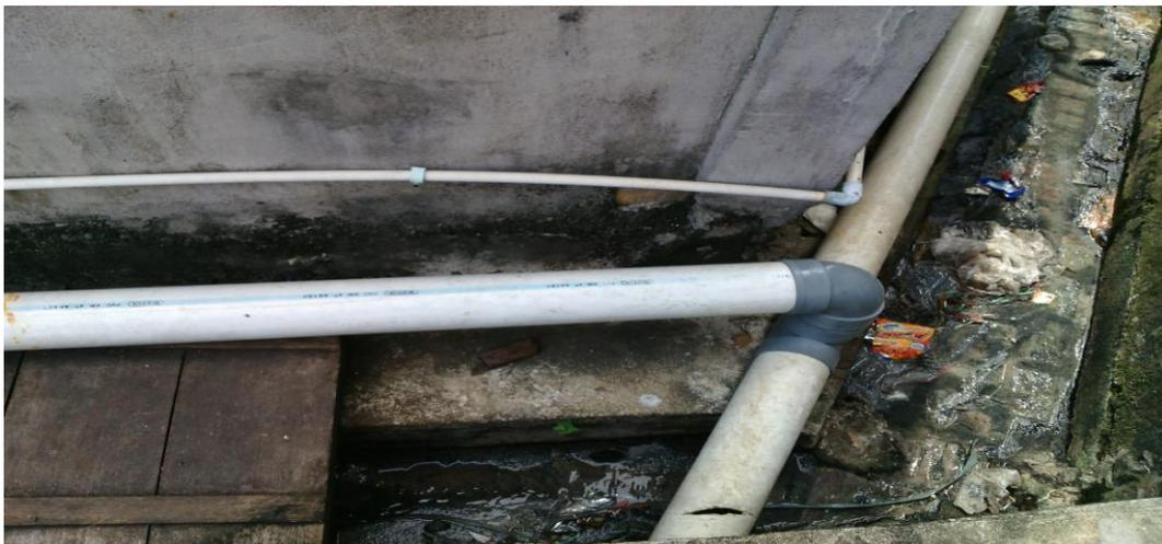
Gambar 2.5 Air limbah industri tahu yang dibuang menggunakan pipa
