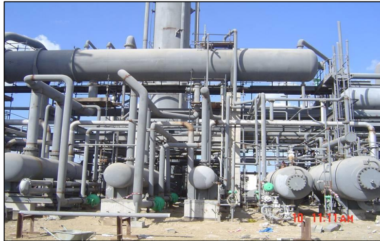
Gambar 2.4 Instalasi Pipa Baja
