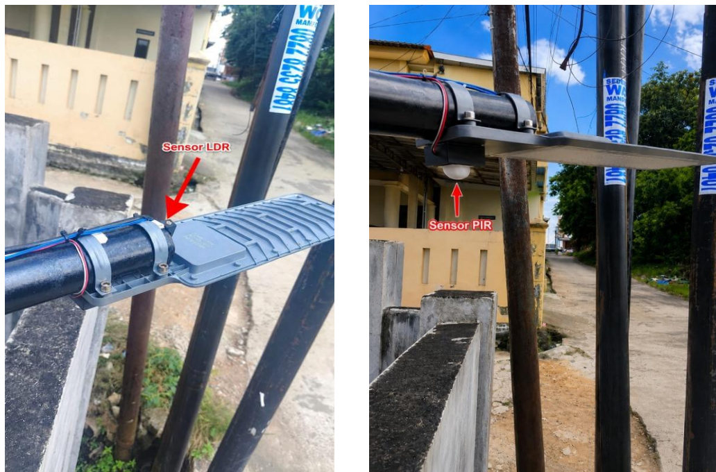
Gambar 4.3 Hasil Pemasangan Sensor LDR & PIR HC-SR501
