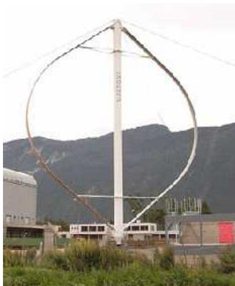
Gambar 2.2 Turbin Angin Sumbu Vertikal
