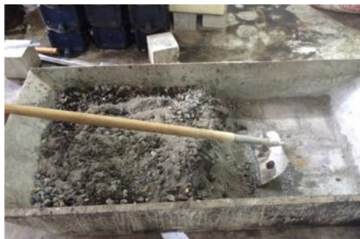
Gambar Pengadukan Material Pengisi Beton
