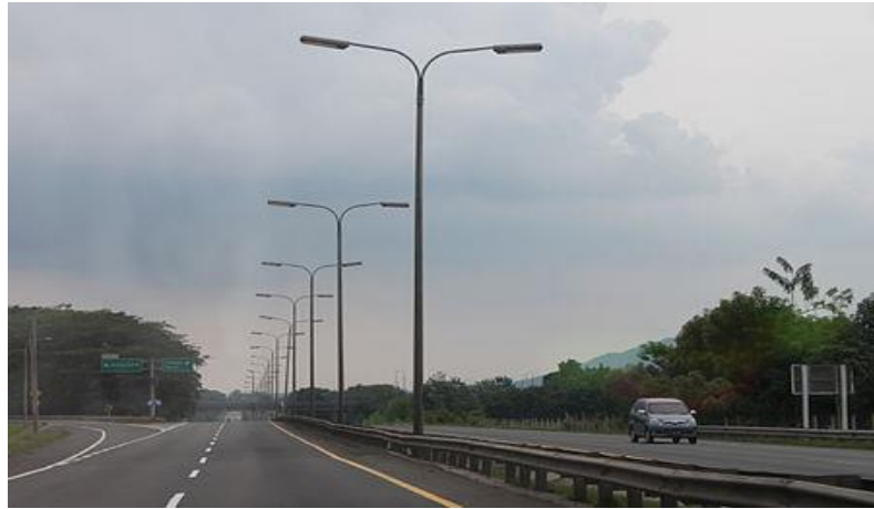
Gambar 2.2 Jalan Nasional (Jalan Tol Jakarta – Merak )
