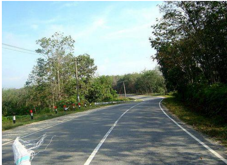
Gambar 2.4 Jalan Kabupaten (Jalan Di Riau)
