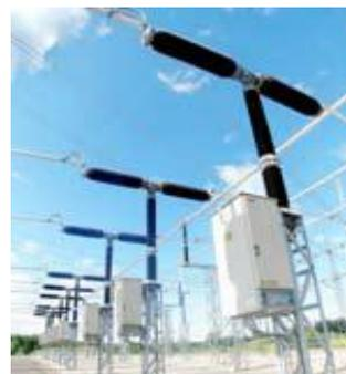
Gambar 2.6. PMT Satu Katup dengan Gas SF<sub>6</sub>
