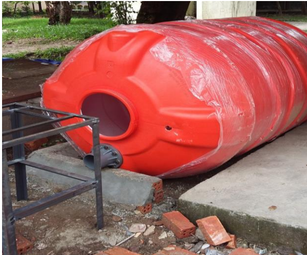
Pengaturan Peletakan Digester
