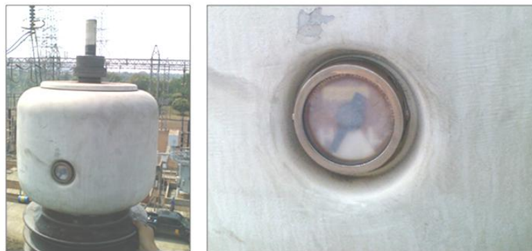
Gambar 2.9 Indikator level minyak bushing
