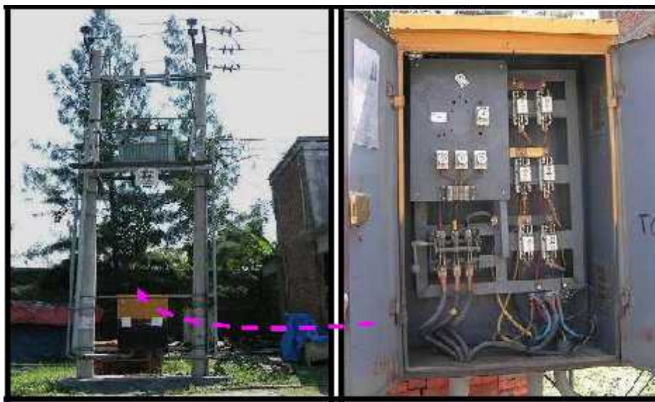
Gambar 2.19 Gardu Tiang Tipe Portal Dan Midel Panel 8
