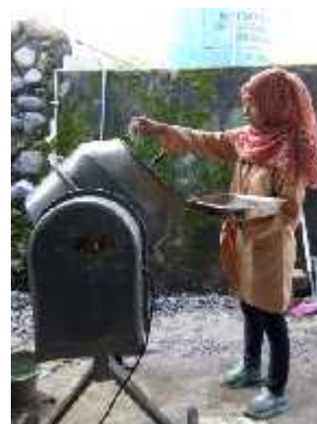
Gambar 15 : Proses pengadukan campuran beton
