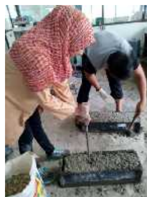
Gambar 17 : Pemadatan adukan beton
