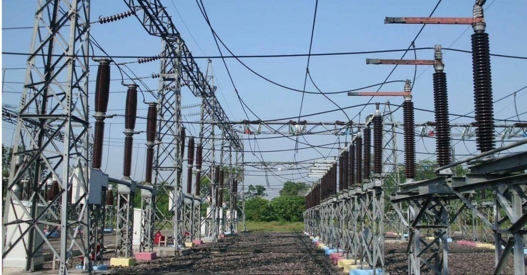
Gambar 2.3. PMT 150 KV
