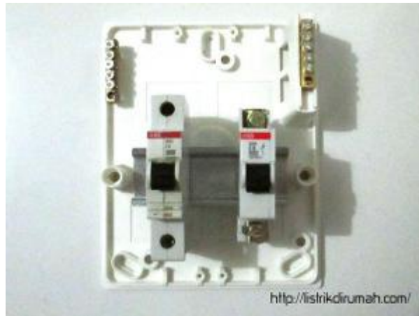
Gambar 2.17 Unit MCB Setelah Terpasang Pada Box 4
