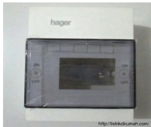
Gambar 2.10 Box MCB Bagian Depan 4
