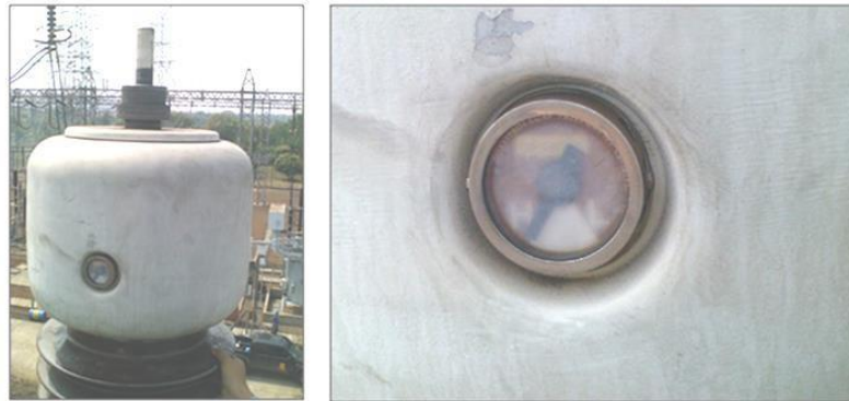
Gambar 2.9 Indikator level minyak bushing
