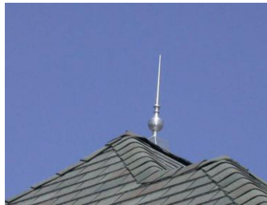
Gambar 2.1. Batang penangkal petir diatas gedung
