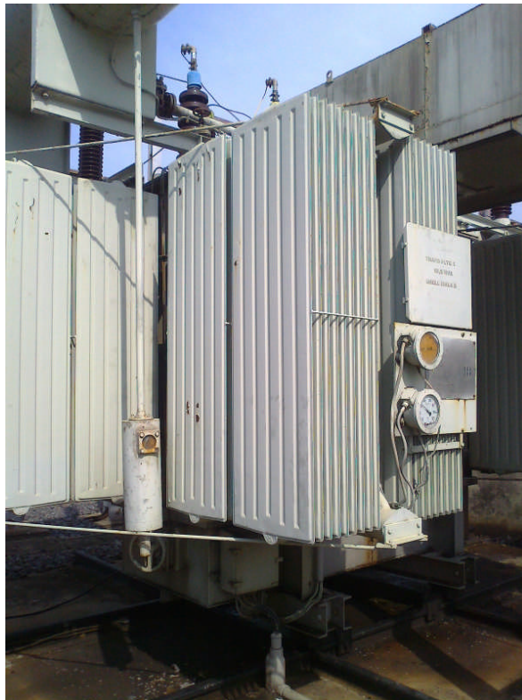
Gambar 2.9 Trafo daya yang ada di PT.PLN sektor Keramasan
