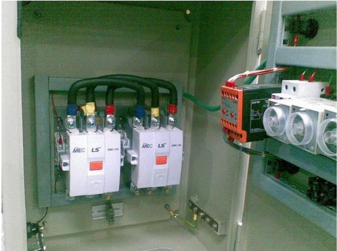
Gambar 2.22 AMF dan ATS ( sumber : panelamf-atasmurah)
