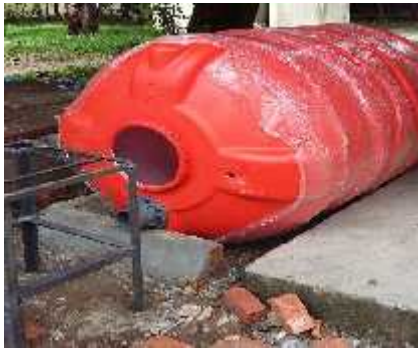
Pengaturan Peletakan Digester
