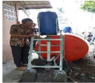
Pengecekan Kebocoran Digester
