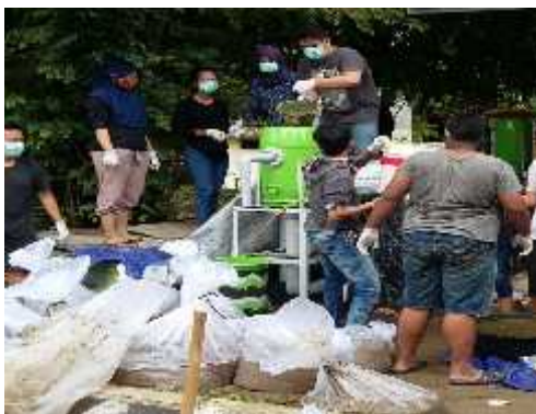
Pemasukan Slurry Ke Dalam Digester
