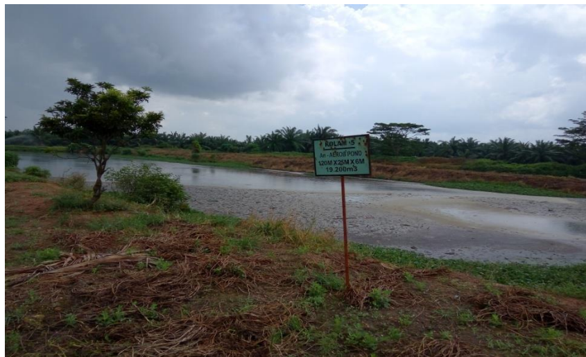
Gambar 6. Anaerob Pond pada PT Perkebunan Mitra Ogan
