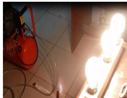
Gambar 33. Uji Nyala Genset
