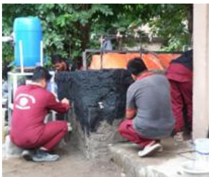
Gambar 24. Pengecatan Digester
