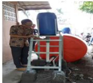
Gambar 23. Pengecekan Kebocoran Digester
