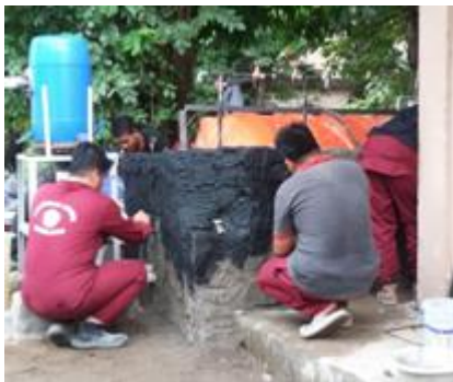
Gambar 24. Pengecetan Digester
