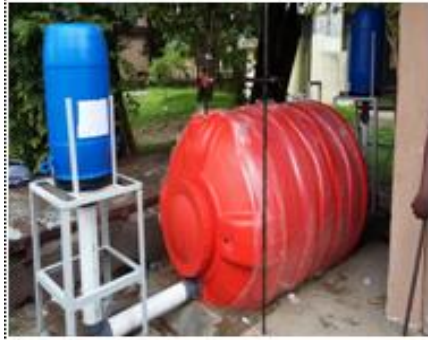
Gambar 22. Pengaturan Peletakkan Digester
