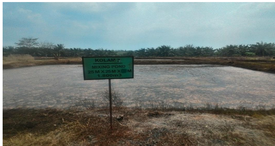
Mixing Pond pada PT Perkebunan Mitra Ogan
