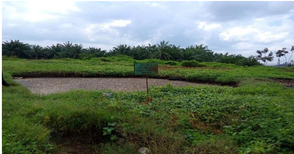
Cooling Pond pada PT Perkebunan Mitra Ogan
