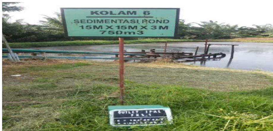
Sedimentasi Pond pada PT Perkebunan Mitra Ogan
