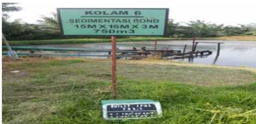
Gambar 14. Sedimentasi Pond pada PT Perkebunan Mitra Ogan
