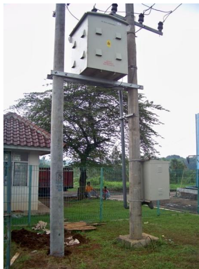
Gambar 2.6 Contoh pemasangan PMCB pada tiang penyulang
