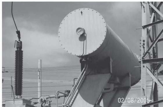
**Gambar 2.3** Tangki atau Konservator Minyak Trafo
