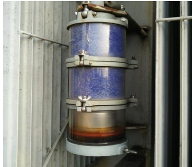
Gambar 2.11. Alat pernapasan, berupa tabung berisi Kristal Zat Hygroskopis
