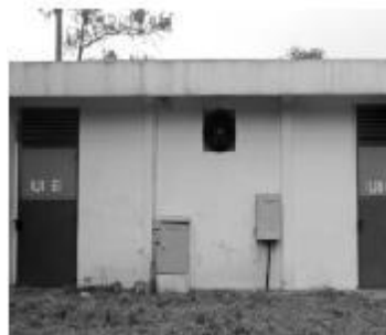
Gambar 2.8 Bangunan Gardu Beton
