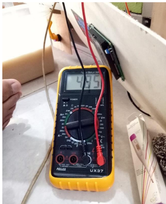
Gambar Pengukuran Tegangan Minuman Kopi, Pada Solenoid Valve Susu
