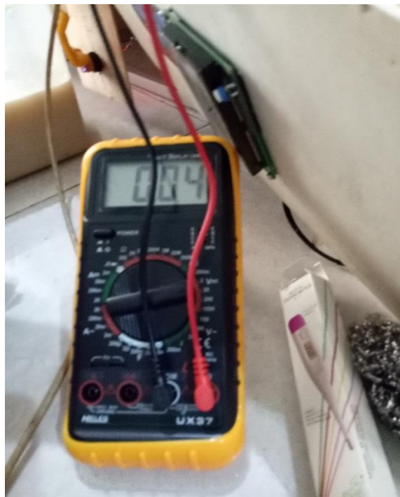
Gambar Pengukuran Tegangan Minuman Kopi, Pada Solenoid Valve Kopi
