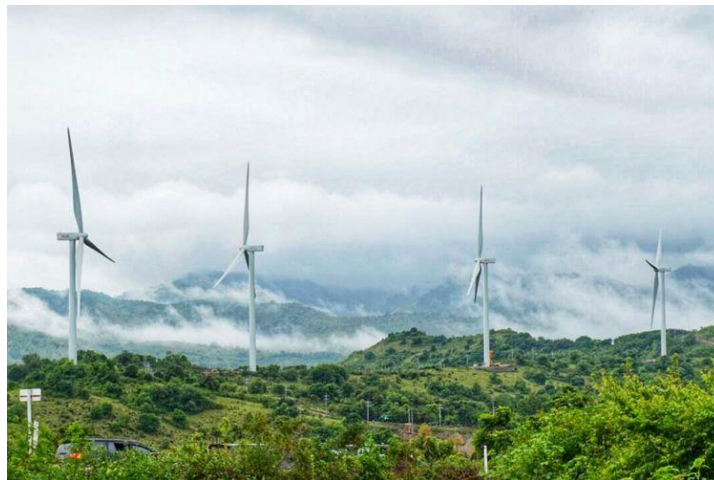
Gambar 2.2 Pembangkit Listrik Tenaga Bayu/Angin di Sidrap (Sumber: lit.1)
