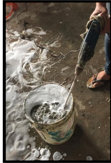
Proses pencampuran mortar dan busa
