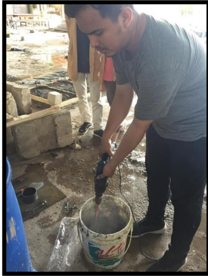
Proses pencampuran adukan mortar
