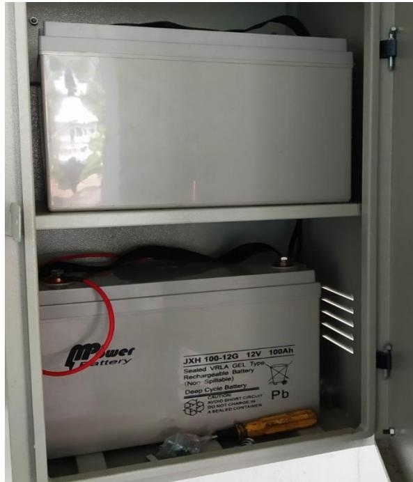
Gambar 2.6 *Baterai Solar Cell*
