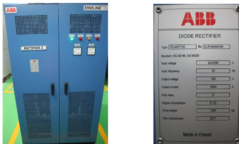
**Gambar 2.6** *Silicon Rectifier* Dan Spesifikasinya
