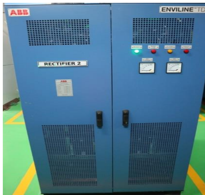
Gambar 2.3 Silicon Rectifier Tampak luar
