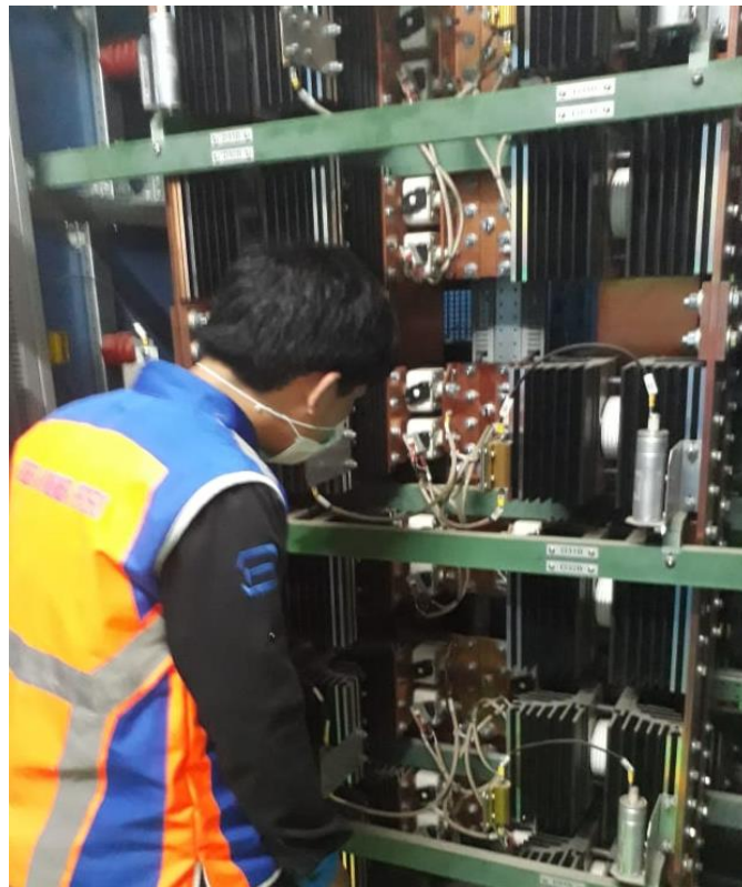
Gambar 2.4 Silicon Rectifier Tampak Dalam
