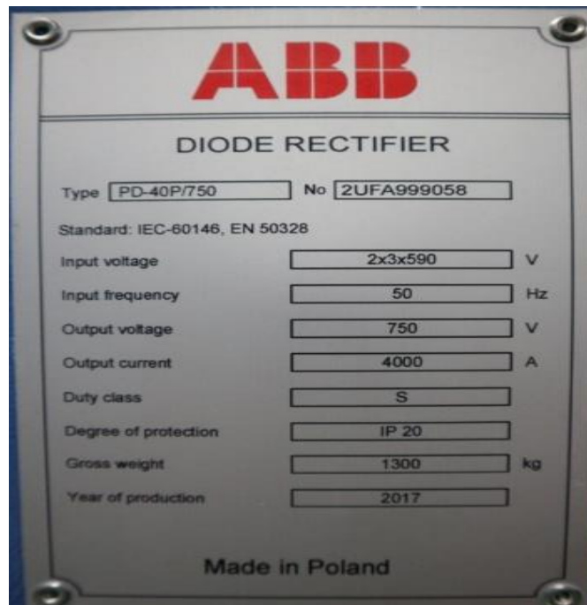
Gambar 2.5 Spesifikasi Silicon Rectifier
