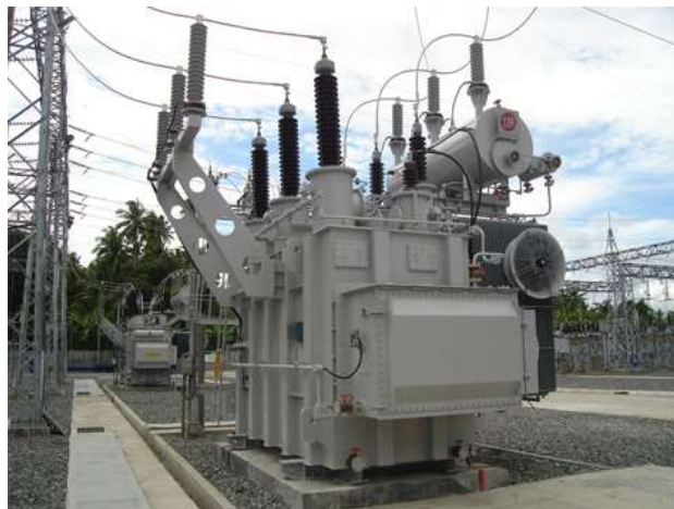
Gambar 2.24 Transformator Tenaga
