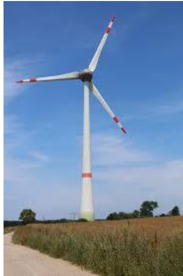
Gambar 2.6 Turbin Angin Sumbu Horizontal
