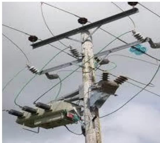
Gambar 2.14 Contoh Letak Pemasangan *Load Break Switch (LBS)*
