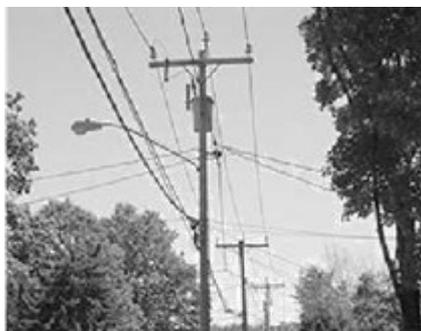
Gambar 2.8 Saluran Udara Tegangan Menengah
