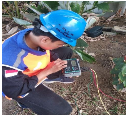
Gambar 2.14 Pengukuran Tahanan Pentanahan
